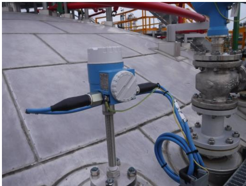
รูปที่ 3.59 อุปกรณ์วัดอุณหภูมิ และระดับของเหลวในถังเก็บโพธิ์หินออกไซด์
