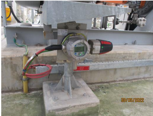
รูปที่ 3.51 ระบบตรวจจับ (Detector)
