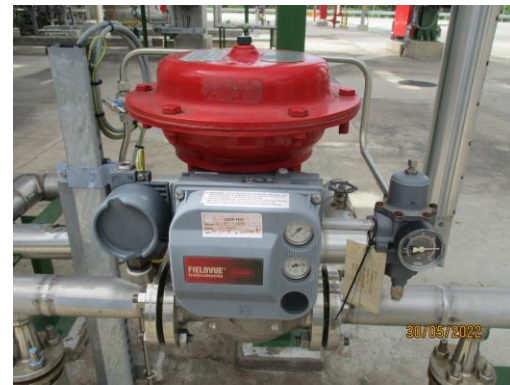
รูปที่ 3.55 อุปกรณ์ความปลอดภัยต่างๆ เช่น Safety Valve (Relief & Vacuum Valve), Shut Off Valve และ Reactor High Pressure Control Valve
