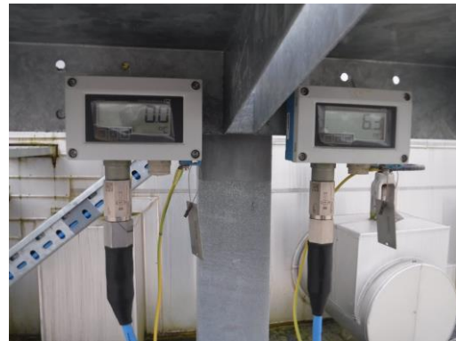
รูปที่ 3.59 อุปกรณ์วัดอุณหภูมิ และระดับของเหลวในถังเก็บโพธิ์หินออกไซด์
