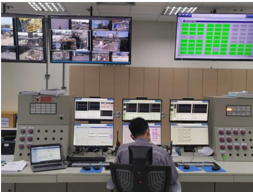
รูปที่ 3.52 ระบบ Distributed Control System (DCS)
