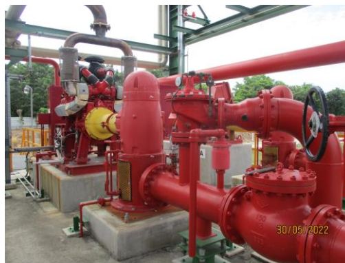
รูปที่ 3.47 เครื่องสูบน้ำดับเพลิง
