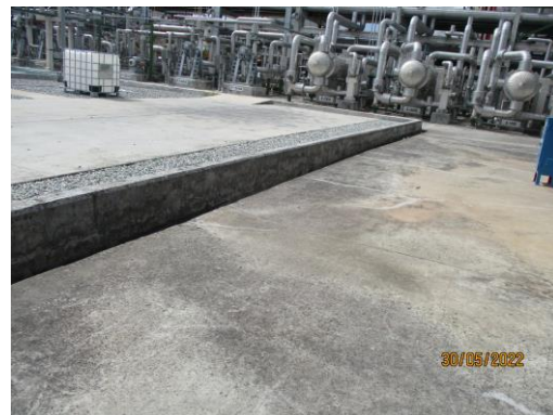
รูปที่ 3.57 คันกันล้นรอบบริเวณปั๊มสูบ โพพิลีนออกไซด์
