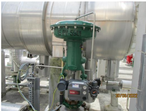
รูปที่ 3.55 อุปกรณ์ความปลอดภัยต่างๆ เช่น Safety Valve (Relief & Vacuum Valve), Shut Off Valve และ Reactor High Pressure Control Valve
